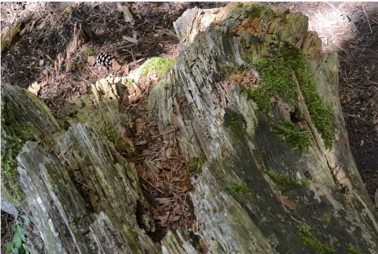
Figure 23 : Pied arbre 2 de la Combe Rougeux
